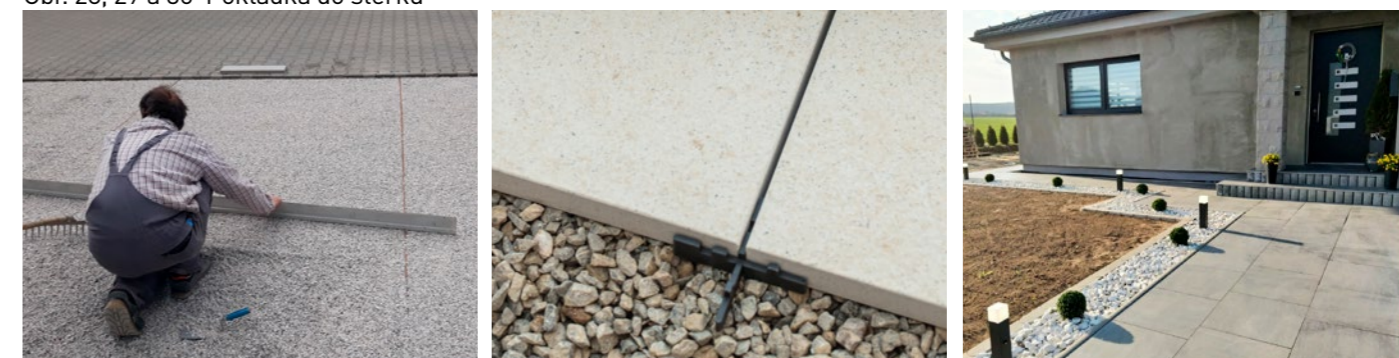
Obr. 28, 29 a 30 Pokládka do štěrku
