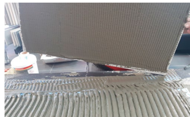
Obr. 10 Lepení metodou buttering-floating
