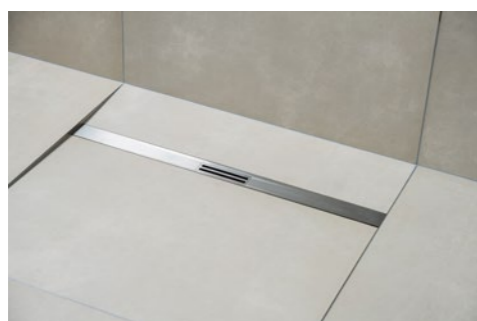
Obr. 22 Použití formátu 80 × 80 cm s vyspádovanou podlahou
